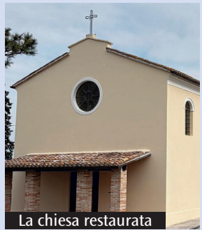
La chiesa restaurata
